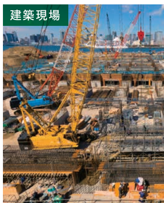
工事の進捗状況を離れた場所から把握。
